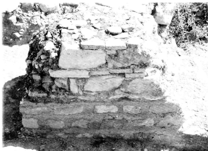
Fig. 10 - Particolare delle fondazioni del pronaos: la parte bassa è quella originale ed è chiaramente sormontata da un tratto di muratura di restauro.
