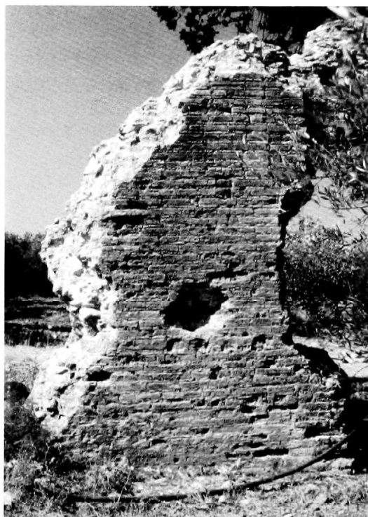
Fig. 5 - Arkades (Ini Monofatsi), resti dell'acquedotto della seconda metà del II sec. d.C. Particolare della muratura.
