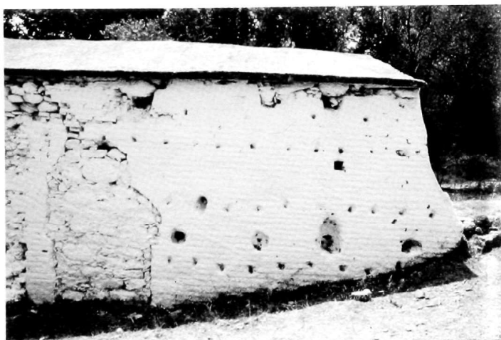
Fig. 9 - Lappa, le piccole terme presso la chiesetta di Santa Domenica. Si notino gli incassi praticati sulla parete per ospitare i chiodi distanziatori per intercapedini.
